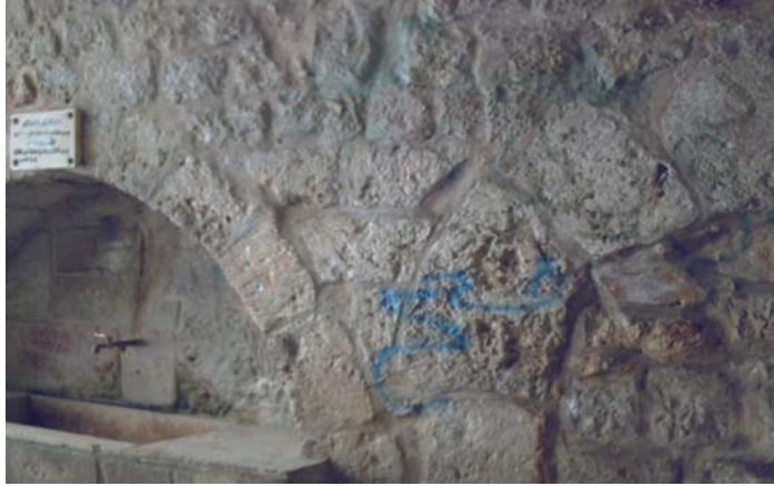
شكل(31.4): صور توضح الفتحة القديمة المغلقة لسبيل الكاس وبجانبها فتحة الحالية المستخدمة.
