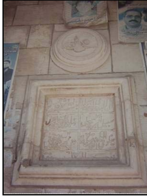
شكل (7.4): صورة توضح واجهة السبيل والأخرى توضح النقش والطغراء في وسط واجهة السبيل المصدر: الباحثة.
