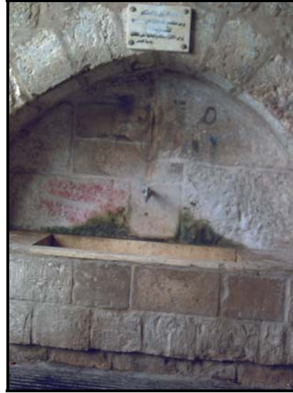
شكل(34.4): صورة توضح البناء الحالي لسبيل الكاس.
